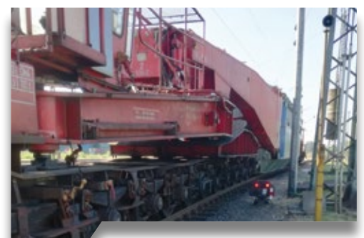
Bild 1: Millimeterarbeit beim Transport eines 273 t Transformators im HPA-Gleisnetz. (Foto: Frank Lackmann, HPA)
